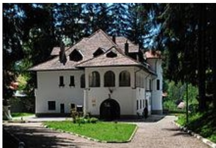
Casa memorială G. Enescu de la Cumpătu, Sinaia
